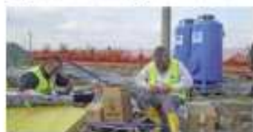
Figura 3: fasi di montaggio dell'impianto
