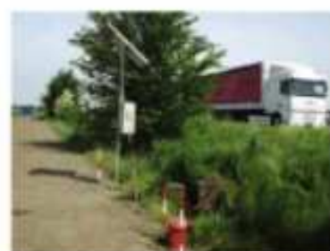
Figura 1: sistema di pompaggio in funzione in un cantiere di bonifica da idrocarburi
